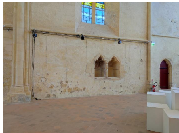
Mur à gauche
