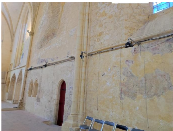
Mur à droite
